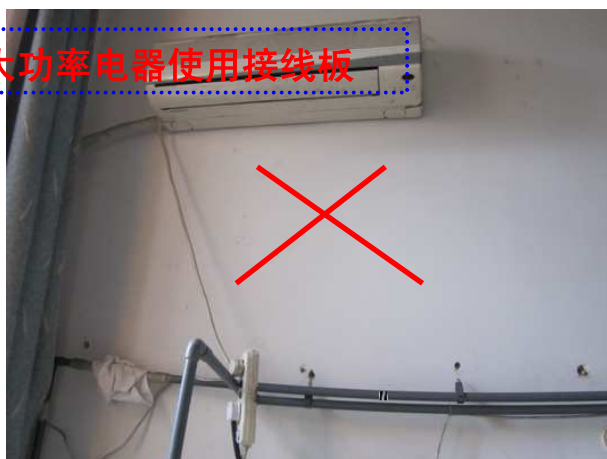
接线板破毁或线路老化
